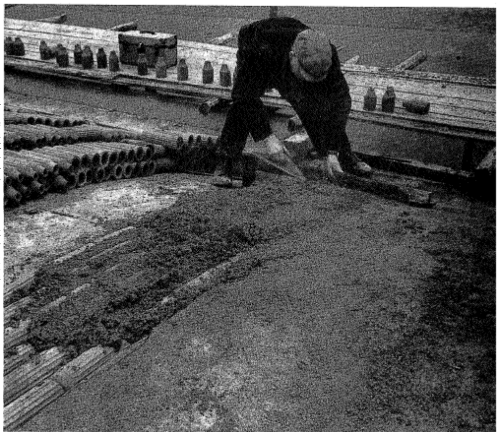
foto 8. het afwerken onder de rei
