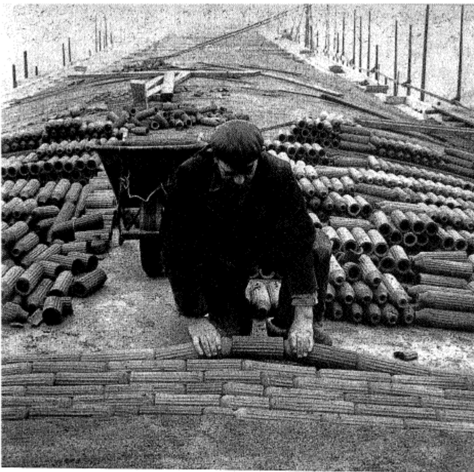
foto 6. het leggen van de fusées met verspringend mofstuk in het midden
